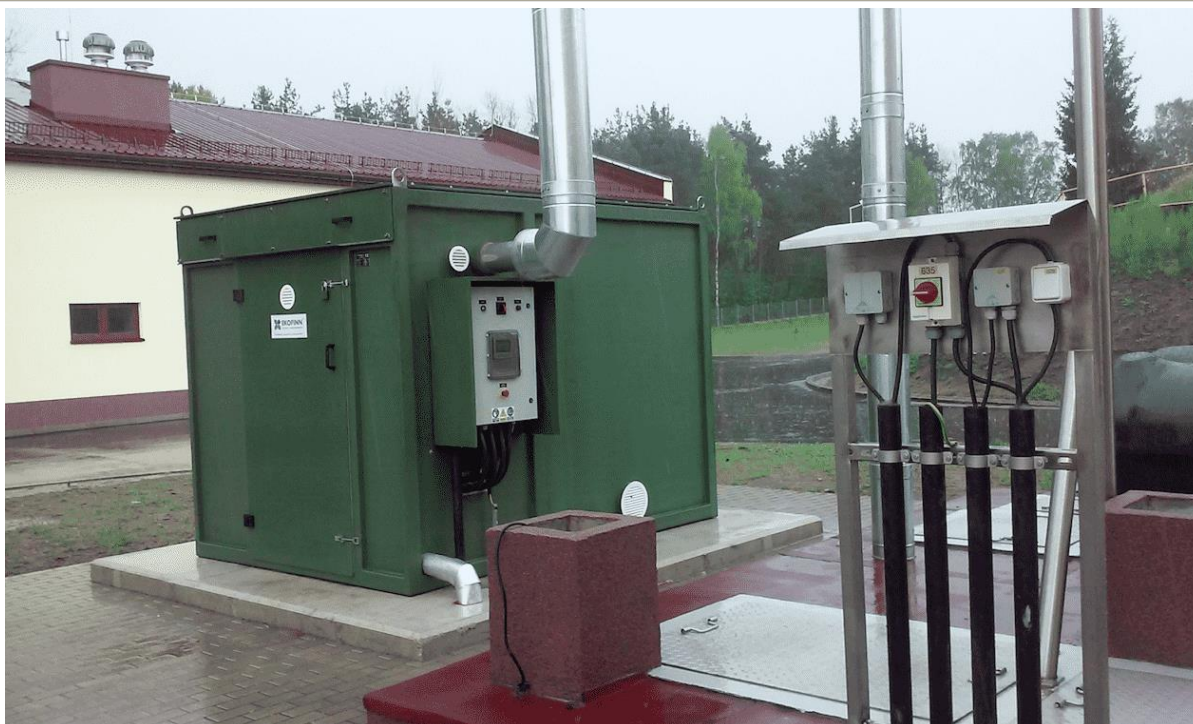
Obrázok 5. Systém biofiltrácie vzduchu.
