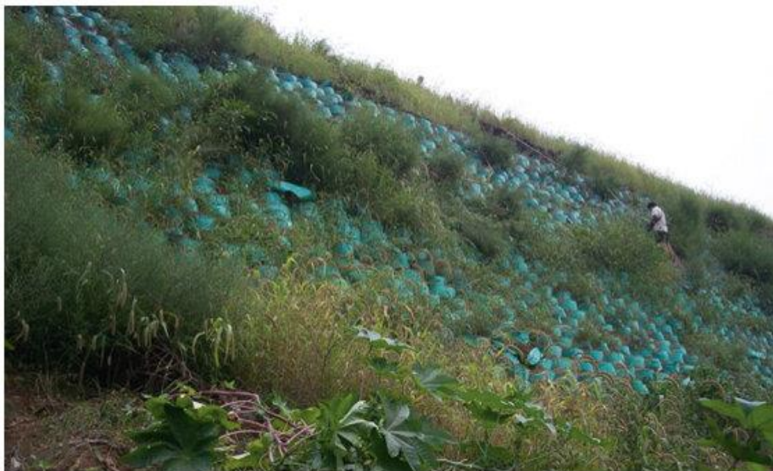
Rysunek 9. Konstrukcja elastyczna i biomimetyczna na stoku osuwiskowym.
