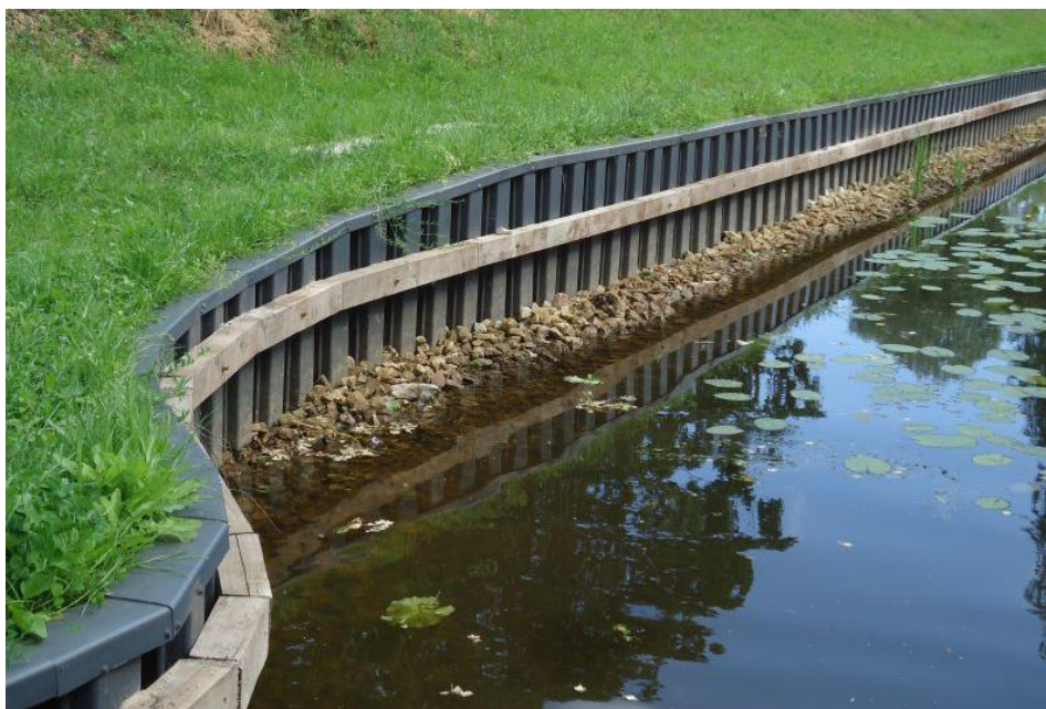
Obrázok 9. Tesná stena vyrobená z vinylových záporových stien, chrániaca breh toku ( https://www.pietrucha.pl/pl/oferta/inzyniera-ladowa-i-wodna/grodzice-wynylowe )
