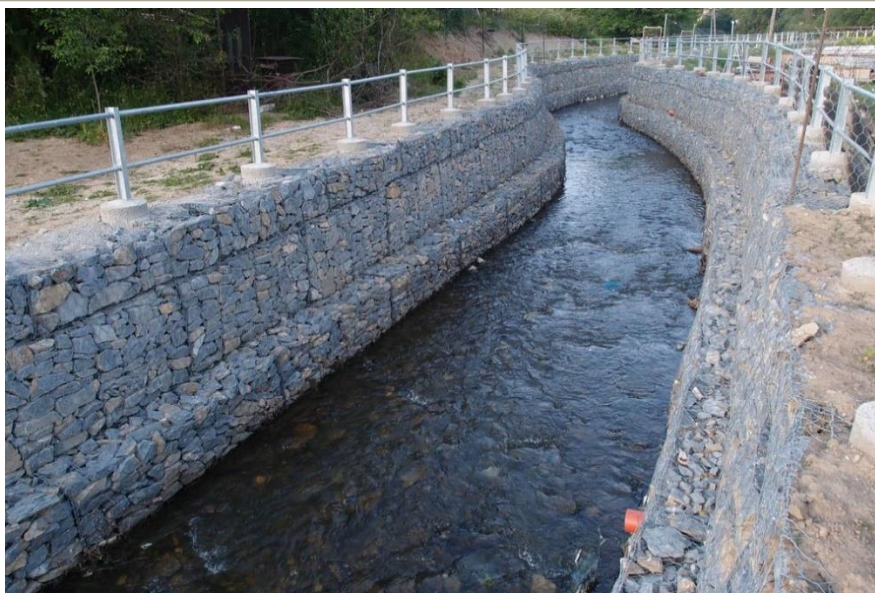
Obrázok 10. Oporné múry vybudované z gabiónov ( https://www.flickr.com/photos )
