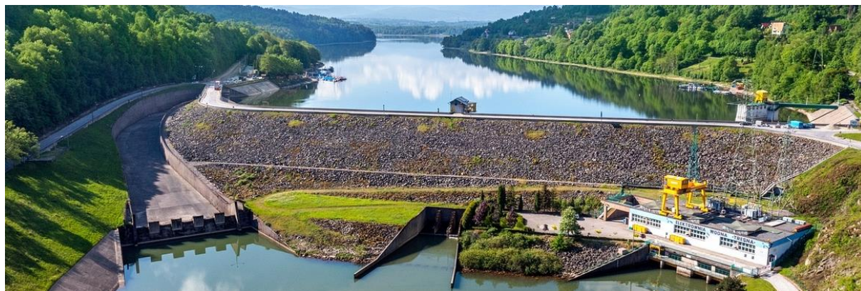
Obrázok 25. Príklad zemnej priehrady s ílovým jadrom ( https://krakow.wody.gov.pl/o-wodach-polskich/zbiorniki-rzgw-w-krakowie ).
