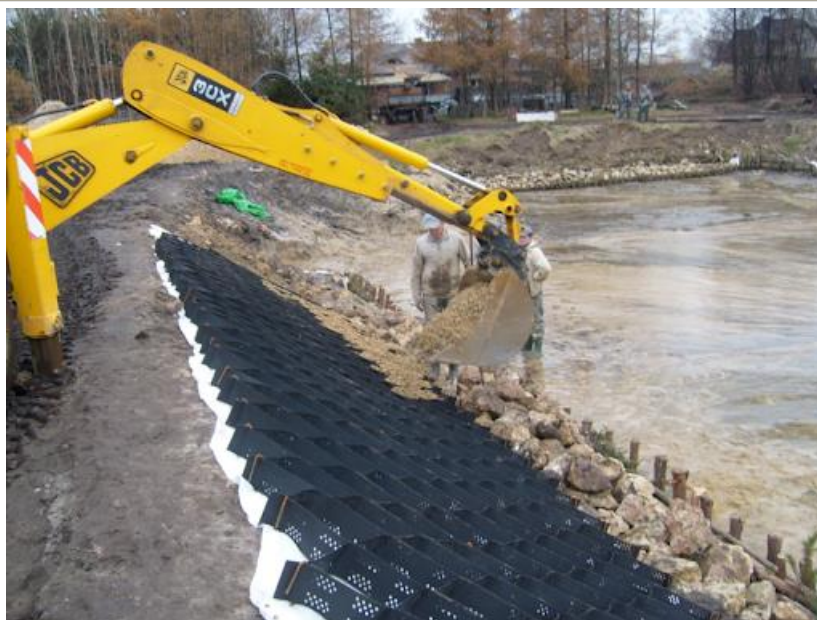
Obrázok 11. Dopĺňanie geokraty štrkovo-kamenným násypom ( http://www.geokrata-geokrata.pl )
