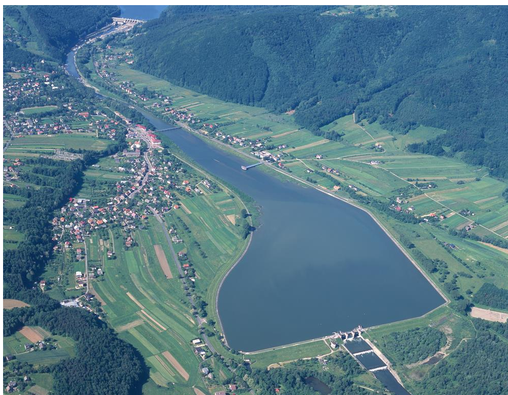
Rycina 20. Zbiornik wyrównawczy (Czaniec) zbiornika energetycznego (Porąbka). ( https://haskoningdhv.pl/projects/jaz-czaniec/ )
