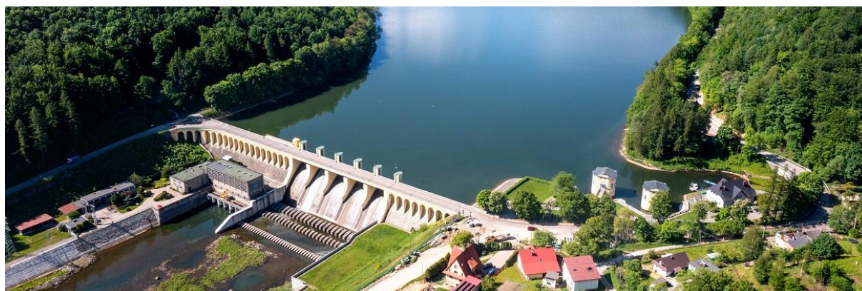
Rycina 26. Przykład zapory betonowej ( https://www.gov.pl/web/wody-polskie-krakow/Zbiorniki ). Zbiornik Poręba jest najstarszym element kaskady Soły, zbudowanym w latach 1921-1936.
