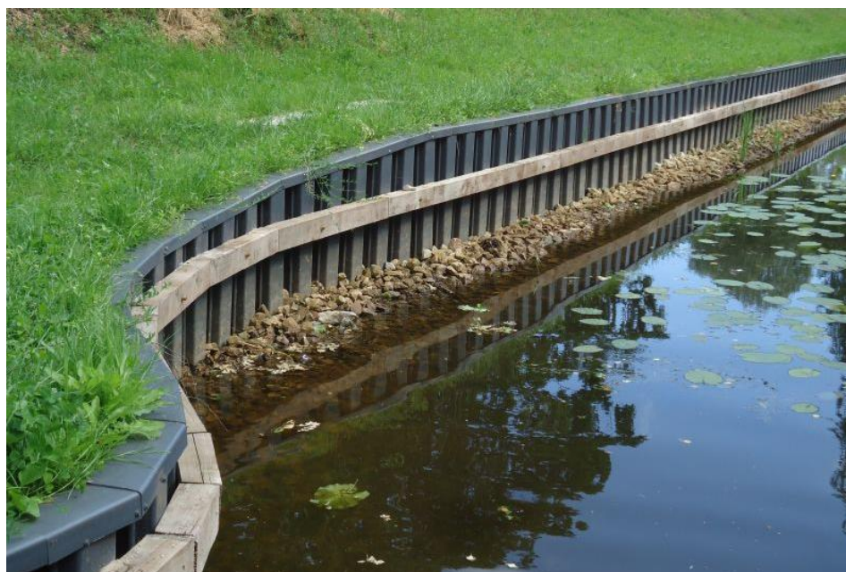
Rycina 9. Ścianka szczelna wykonana z grodzic winylowych zabezpieczająca brzeg ciek (https://www.pietrucha.pl/pl/oferta/inzyniera-ladowa-i-wodna/grodzice-winylowe)
