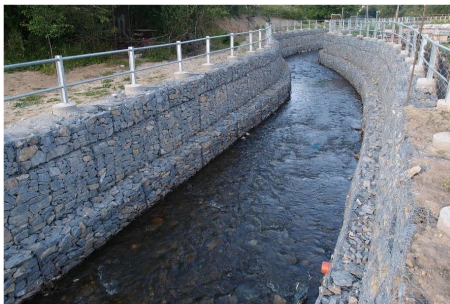
Rycina 10. Mury oporowe wykonane z gabionów ( https://www.flickr.com/photos ).
