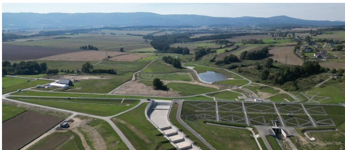
Rycina 22. Suchy zbiornik przeciwpowodziowy ( https://24kłodzko.pl/wody-polskie-zakoczyly-budowe-zbiornika-przeciwpowodziowego-w-krosnowicach/ ).
