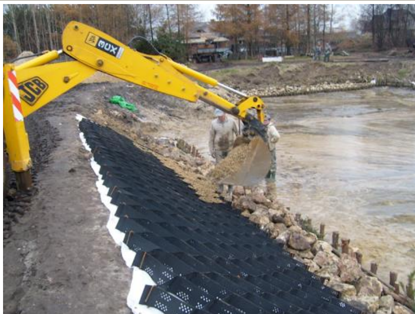
Rycina 11. Uzupelnianie geokraty narzutem żwirowo- kamiennym ( http://www.geokrata-geokrata.pl ).
