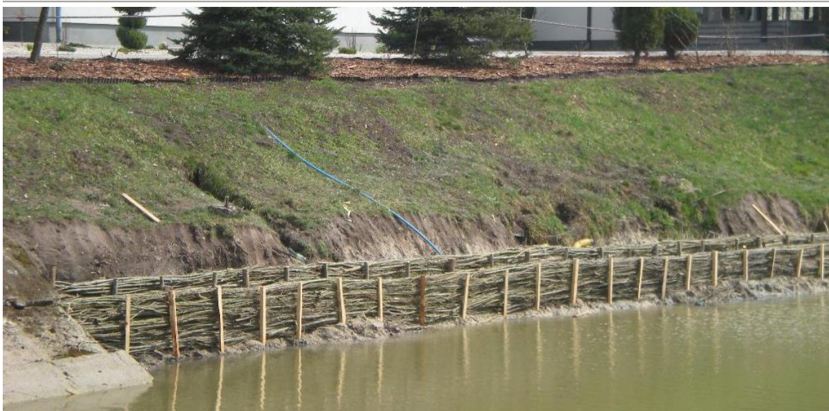
Rycina 14. Brzeg umocniony faszyną ( https://www.favore.pl/420653_kiszka-faszynowa-umacnianie-brzegow-stawow-rzek-oczek-wodnych-sanok-warszawa-radom-podkarpackie.html ).
