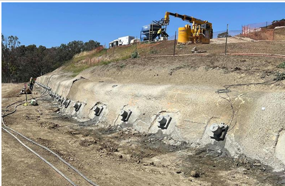
Obrázok 11. Príklad zosuvového svahu stabilizovaného kotvením.
