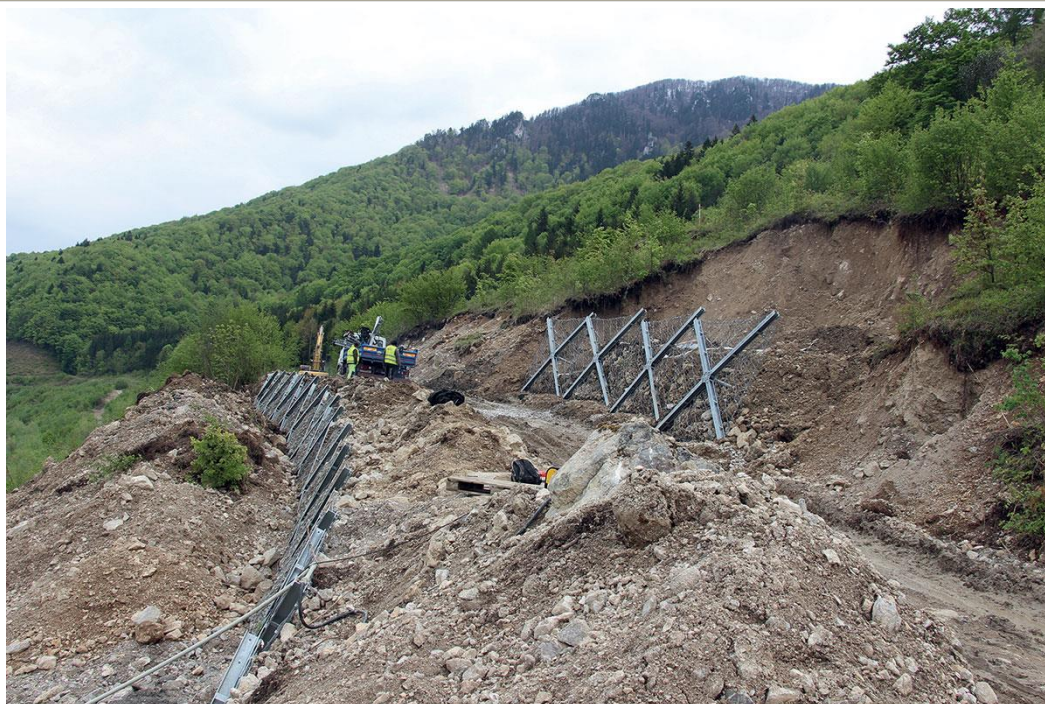
Rycina 11. Przykład zabezpieczenia stoku osuwiskowego przy wykorzystaniu metalowych konstrukcji oporowych
