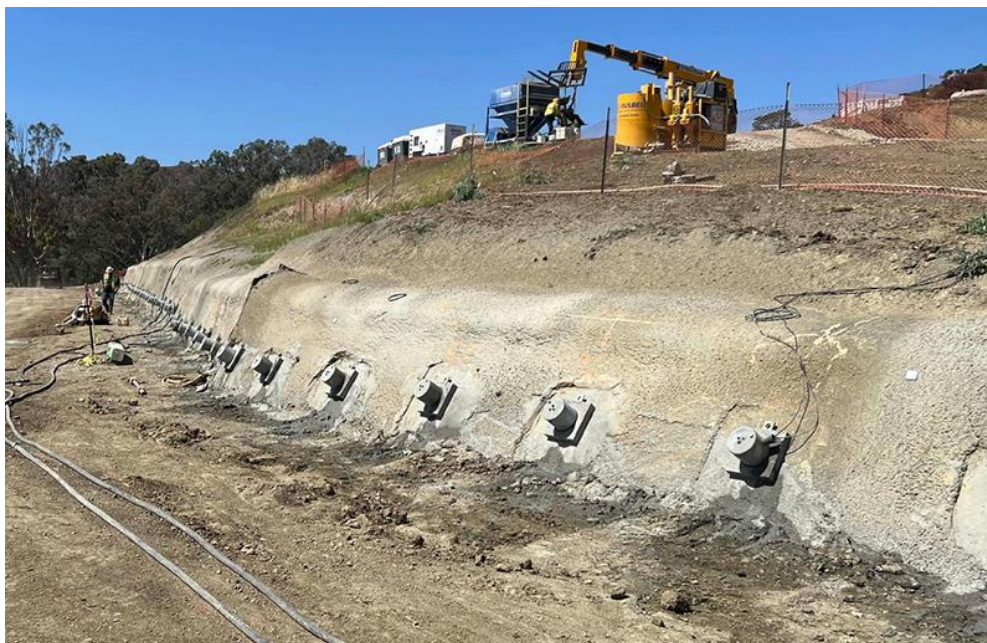
Rycina 11. Przykład stoku osuwiskowego zastabilizowanego przez kotwienie.
