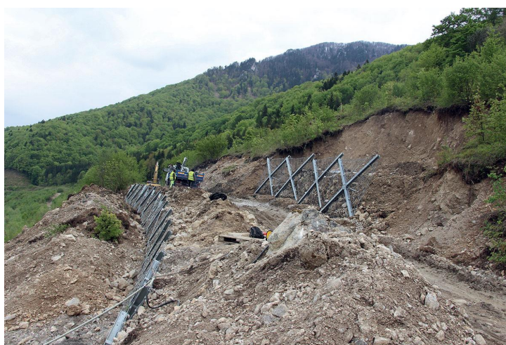
Obrázok 11. Príklad zosuvového svahu stabilizovaného kotvením.
